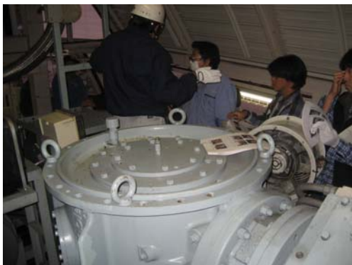
自動循環式索道の予備原動装置の取扱い救助訓練
